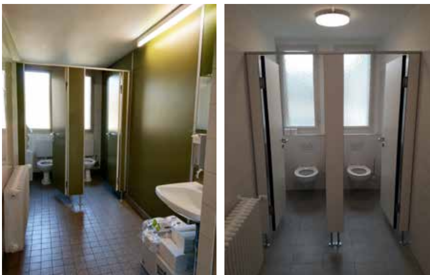
Aus alt mach neu: die WC-Anlagen im Bibliotheksgebäude.
