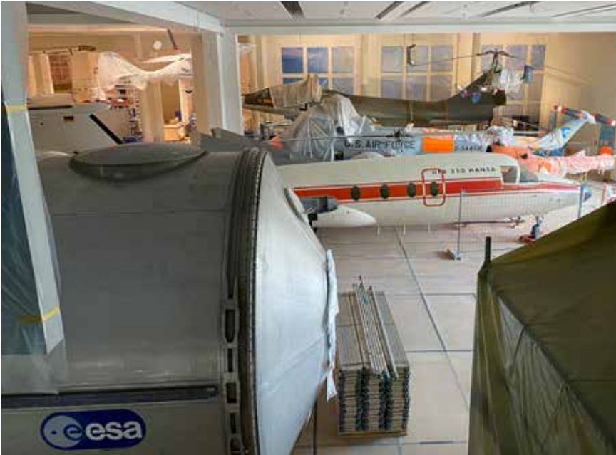
Blick in die Baustelle der Modernen Luftfahrt.
