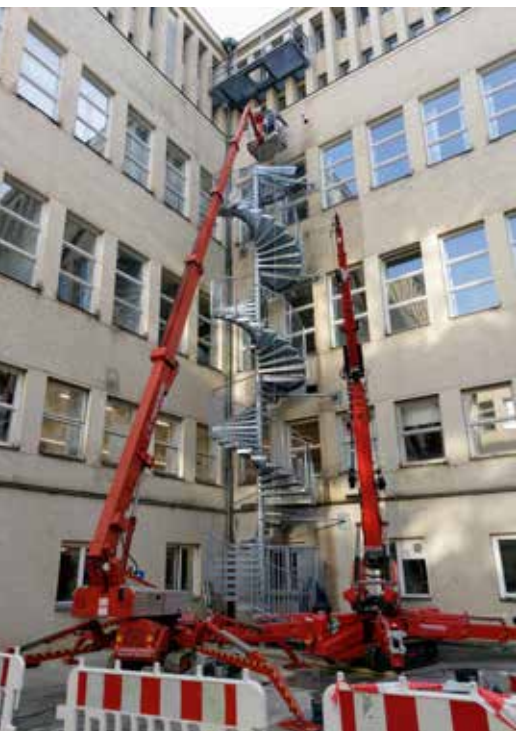
Montage der neuen Fluchttreppe im Parkhof.
